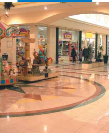
Ejemplo de colocación de gres porcelánico - Centro comercial Zanchetta - Treviso (Italia)
