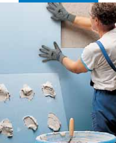
Colocación de planchas de poliestireno con Keraflex blanco
