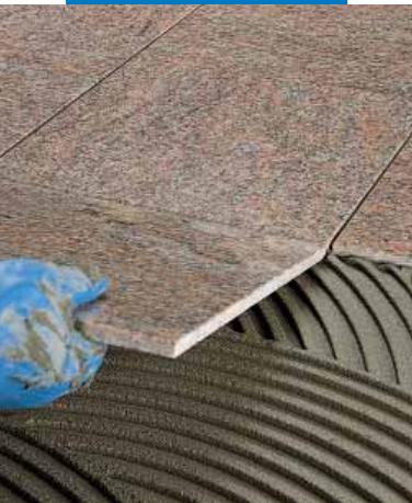
Colocación de mármol preplido en pavimento
