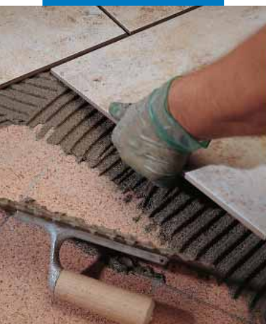
Sobreposición de un revestimiento de baldosas de monococión sobre baldosas hidráulicas ya existentes
