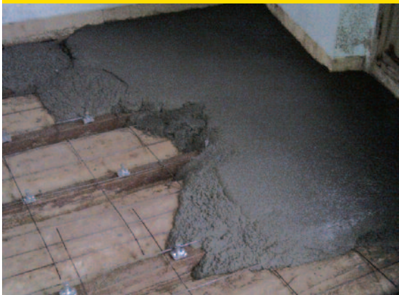
Obra cubierta parking - Benidorm
