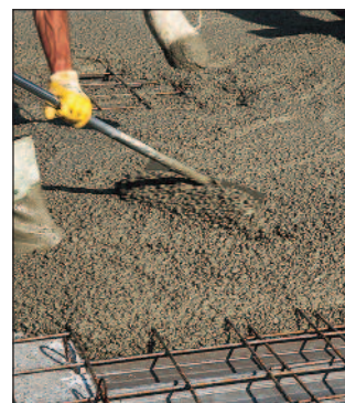
1 Laterlite Beton 1600 y 1400, hormigón estructural. 2 Armadura
